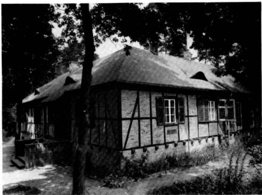
Jochen Klepper-Haus (Blick von der Potsdamer Chaussee)
